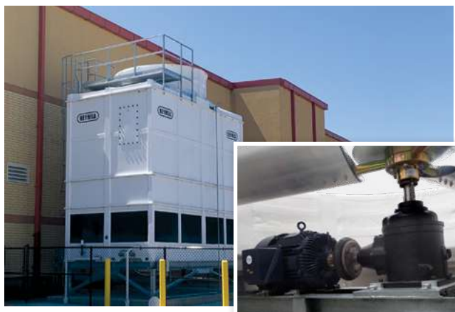
Torre de 1 ventilador Estándar: Sistema de transmisión con caja reductora
